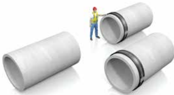
Rohrspitzen ausrichten.
